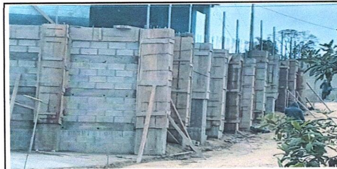
Foto 6: se puede apreciar las columnas ya fundidas del Mejoramiento de muro de contención con concreto lanzado y drenes suroeste.
