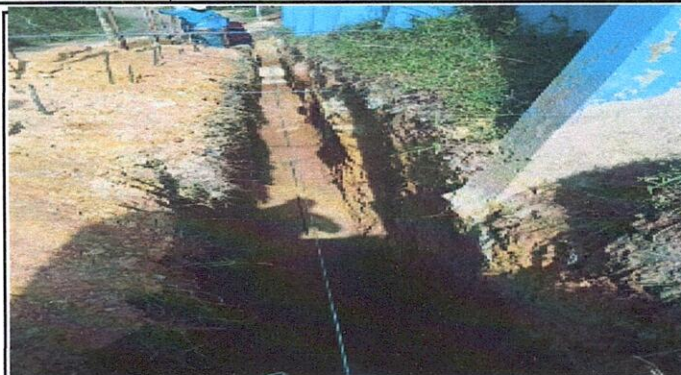
Foto 2: Se observa el ancho y profundidad del sanjeo a nivel del suelo, para iniciar con las columnas en el Mejoramiento de muro de contención con concreto lanzado y drenes.
