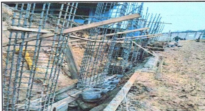
Foto 4: Se aprecia las columnas ya paradas, en el Mejoramiento de muro de contención con concreto lanzado y drenes
