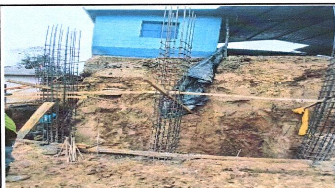
Foto 3: se observa el arduo trabajo, avanzando cada día con las columnas, en el Mejoramiento de muro de contención con concreto lanzado y drenes
